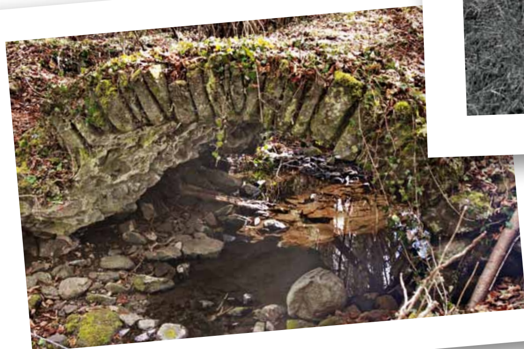
Ponceau sur un affluent du ruisseau Mirabel (XIX e siècle) (Marscoïn-Malauzat)
